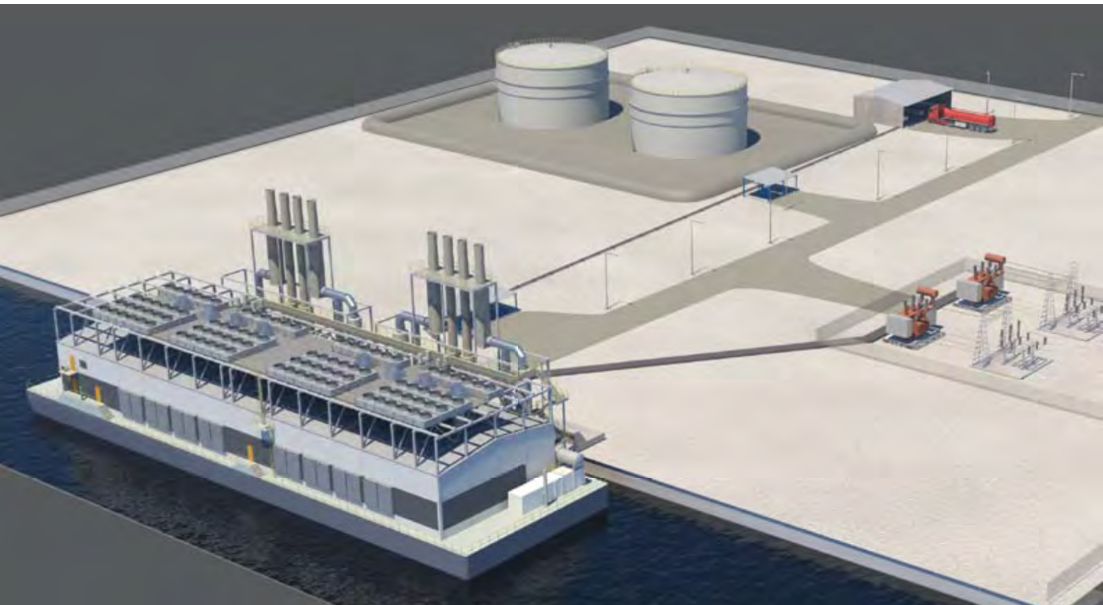
БАРЖА-ЭЛЕКТРОСТАНЦИЯ WÄRTSILÄ 32 : РАЗМЕРЫ
