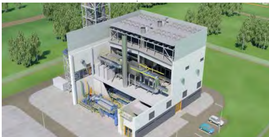
Рис 4. Динамическая ТЭЦ имеет два этажа, на первом этаже - генераторная установка и вспомогательное оборудование, а на втором - система вентиляция, утилизации тепла выхлопных газов и оборудование для снижения выбросов.
